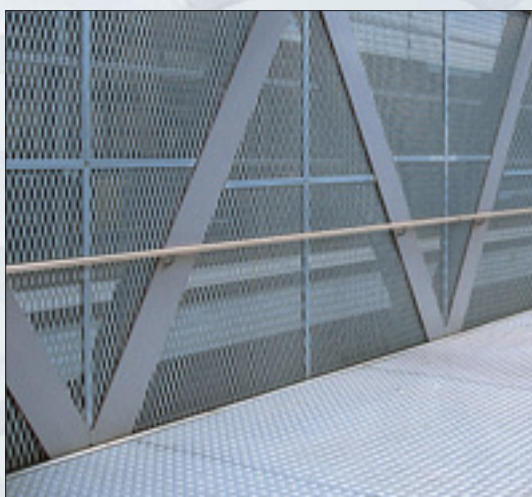
SP 2 - DL 110 x DC 40 (41,6) - av 9,5 x sp 4 mm Ferro zincato a caldo
