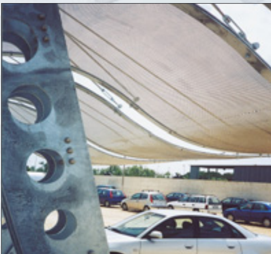
FILS 20 - DL 45 x DC 15 (11,4) - av 3,3 x sp 2 mm Acciaio AISI 304
